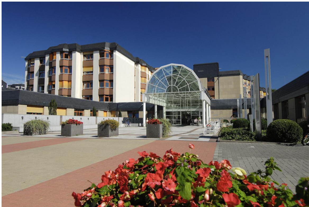
(Eingangsbereich des St. Nikolaus-Stiftshospitals)
